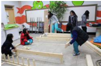
설치 작업 - D.I.Y
