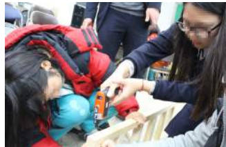
설치 작업 - D.I.Y
