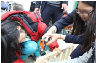
설치 작업 - D.I.Y
